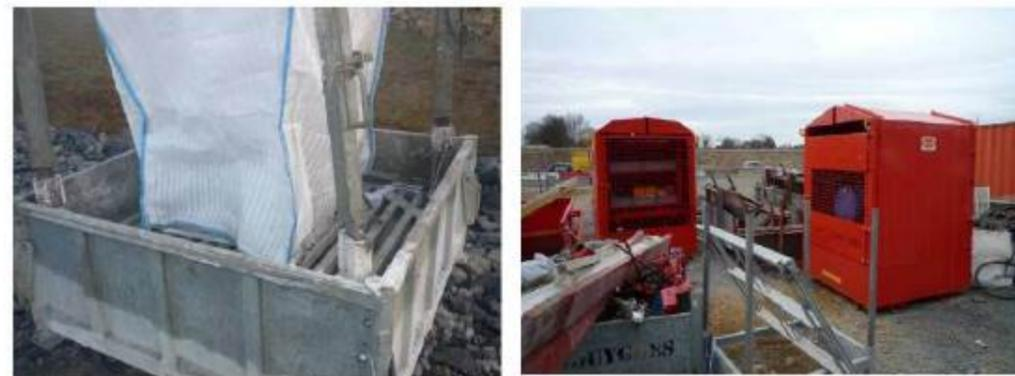
Figure 163 : Système de lavage des goulottes des toupies béton dans un big-bag (à gauche) et système de stockage de produits polluants (à droite) - Source Egis
